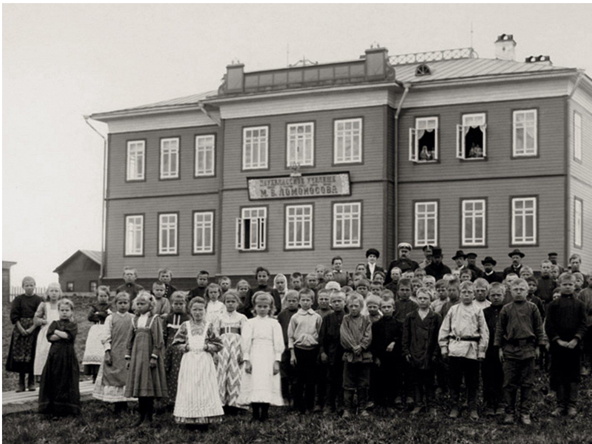
Enseignants et élèves de l'école primaire Lomonossov en deux ans (deux niveaux d'enseignement), devant le nouveau bâtiment de l'école, au bord de la rivière Kouropolka. 1911 Photo : IHMC RAS / Histoire de la Russie en photographies
